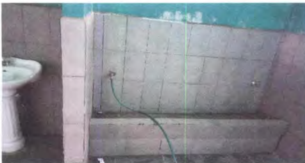
Foto 5: Sustitución de mingitorios por mingitorios de porcelana e instalación de sistema de drenaje
