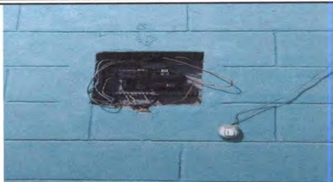
Foto 2: Sustitución de Tablero eléctrico.
