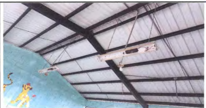
Foto 6: Sustitución de lámparas con cableado, ducto y accesorios
