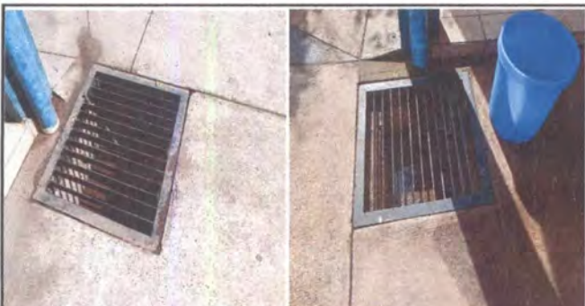
Foto 5: Mejoramiento a las cajas de registro de bajadas de agua pluvial con lámina desplegada para evitar el ingreso de partículas.
