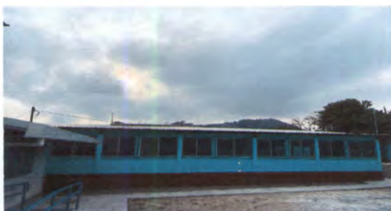
Foto 3: Instalación de balcones en todas las aulas.
