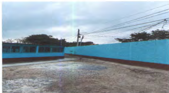
Foto 7: Pintura en el muro exterior
