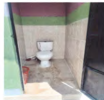
Foto 6: Vista de otro sanitario del establecimiento.
