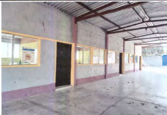
Foto 9: Vista de las ventanas de adentro de las aulas.
