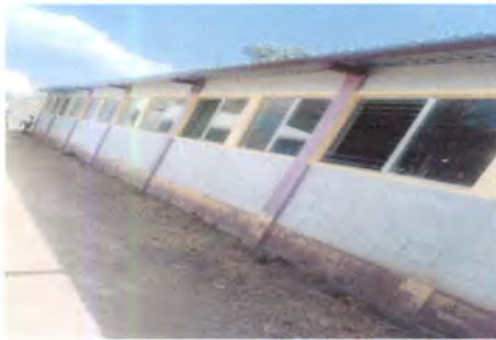
Foto 3: Vista de la pared de afuera de las aulas que da para el patio.
