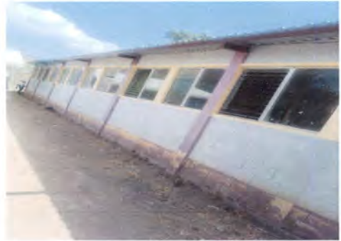
Foto 8: Vista de las ventanas que dan para el patio.
