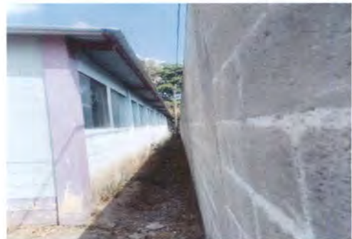
Foto 10: Vista de las ventanas de afuera de las aulas.
