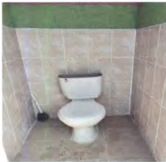
Foto 5: Vista de un sanitario del establecimiento.
