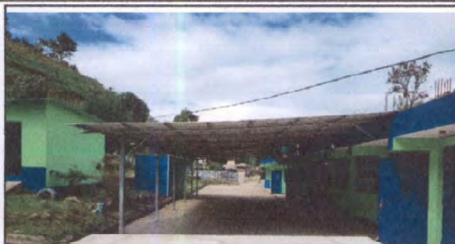
Foto 1: Ampliación de fabricación de techo principal en el patio de la escuela. Medidas 7.70*20mts.
