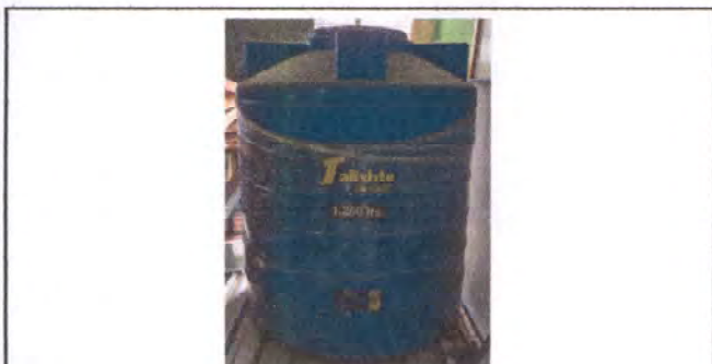
Foto 5: Instalación de depósito de agua
