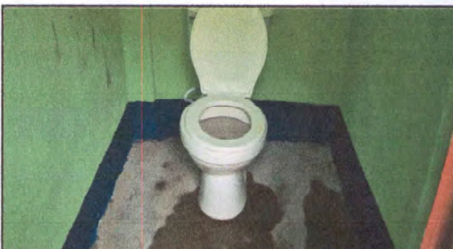
Foto 4: Sustitución de accesorios inodoro (contra llave, tubo de abasto y tanque)
