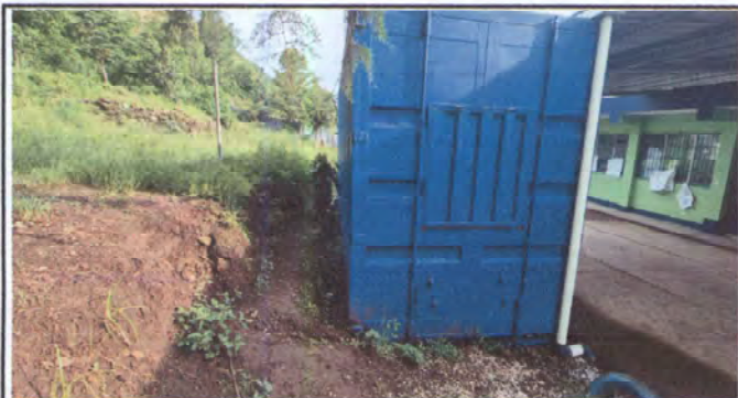
Foto 7: Protección para el área de cocina, para evitar corrosión por el agua y lodo, se realizará con block a una altura de 1.5 metros con cuneta para descarga de agua pluvial
