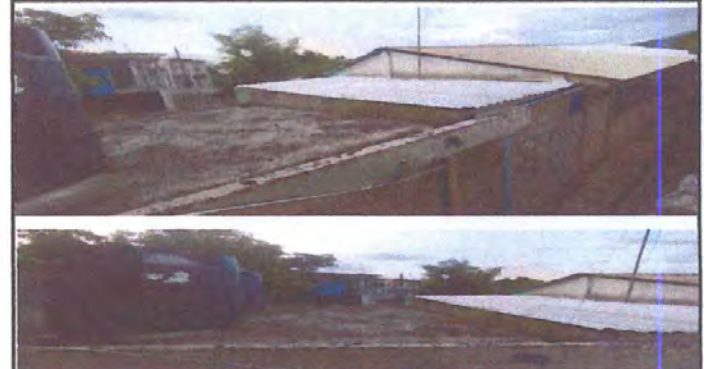
Foto 10: Impermeabilización de losa
