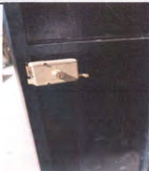
Foto 1: Cambio de chapa de 1 salón
