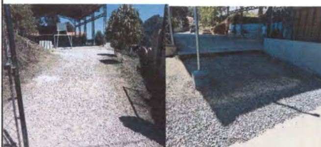
Foto 2: Sstitución de torta de concreto entrada del centro educativo
