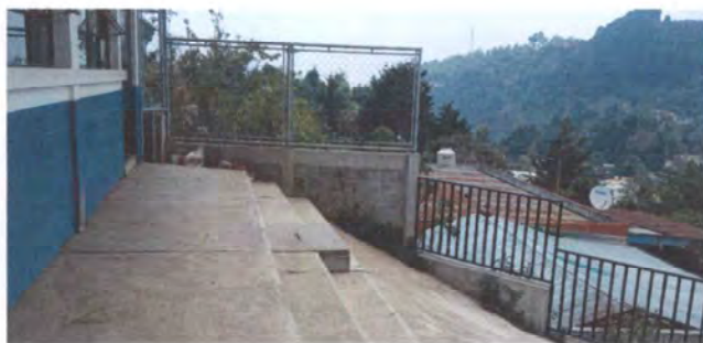
Foto 9: Instalación de pila y chorro
