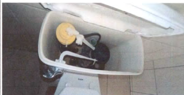
Foto 4: Sstitución de accesorios de 4 inodoros
