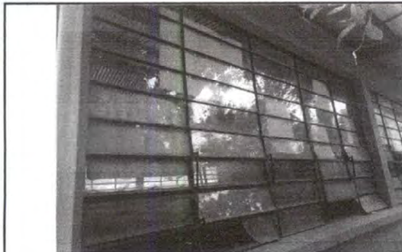
Foto 7: Se harán 11 sustituciones de vidrio (Renglón 5.5) y sustitución de ventanas de metal (renglón 19.17).
