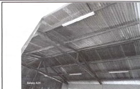
Foto 2: Se Cambiarán 20 X 11.25 metros de techo (renglón 1.1) a 2 aguas, con sus respectivos capotes (renglón 1.1) y elementos de fijación (renglón 1.3) Remodelación de iluminación y fuerza.
