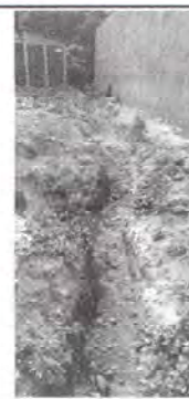
Foto 10: por el momento se hacen ajustes manuales de tierra para que no ingrese el agua a las aulas en tiempo de invierno.
