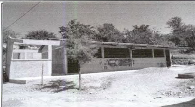
Foto 1: Aulas que tiene el centro educativo: se pintarán paredes (renglón 9.1), remodelarán la iluminación (renglón 17.3), sustitución de flujos (renglón 17.9) y fuerza (renglón 17.11), reparación de puertas (renglón 4.3) y chapas (renglón 4.2)
