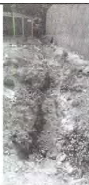
Foto 9: Se espera agregar 25 metros lineales de cuneta (renglón 8.1) para las caídas de aguas pluviales.
