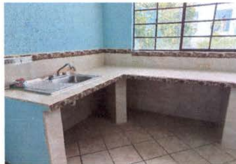
FOTO 2: INSTALACIÓN DE AZULEJO EN COCINA
