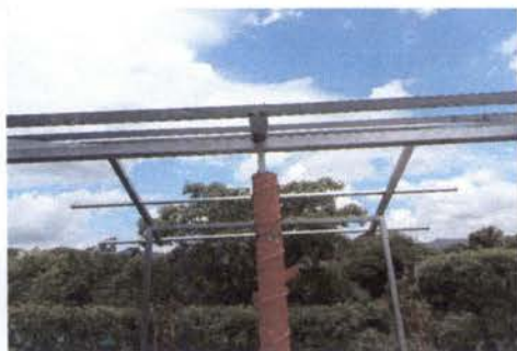
FOTO 1: SUSTITUCIÓN DE ESTRUCTURA DE SOPORTE DE MADERA POR METAL, FALTA INSTALACIÓN DE LÁMINA TROQUELADA CALIBRE 26
