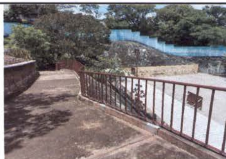
FOTO 6: MANTENIMIENTO A BARANDAS DE METAL
