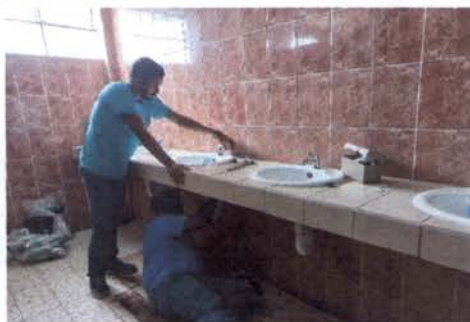
FOTO 3: SUSTITUCIÓN DE MEZCLADORAS EN 6 LAVAMANOS
