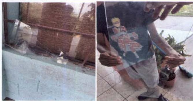
Foto 1: Sustitución de vidrios en ventanas de aulas
