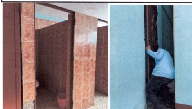
Foto 6: Mantenimiento a puertas de metal de los baños y fabricación e instalación de puertas de metal
