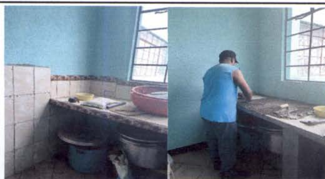
Foto 3: Instalación de azulejo de cocina
