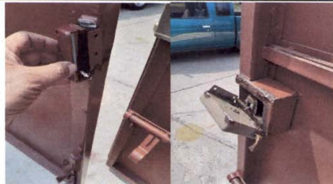
Foto 2: Sustitución de Chapa
