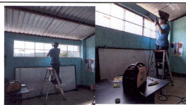
Foto 4: Sustitución de estructura de metal de ventana
