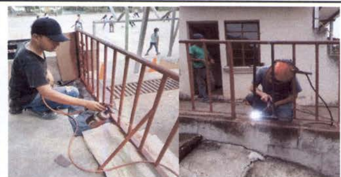
Foto 5: Mantenimiento a baranda de metal
