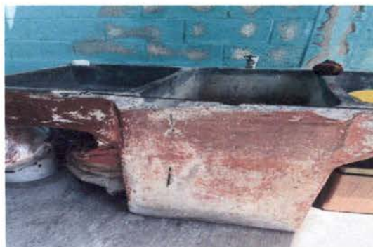
Foto 6: sustitucion de pila de cemento
