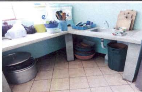
Foto 5: Instalacion de azulejo en cocina
