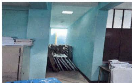
Foto 4: Fabreicacion e instalación de puertas de metal
