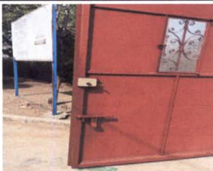
Foto 3: Sustitución de chapa
