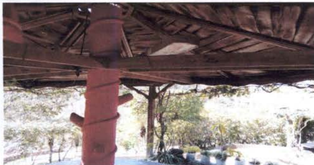
Foto 1: Sustitución por lámina troquelada
