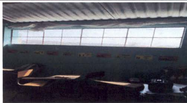
Foto 4: Sustitución de estructura de metal de ventana
