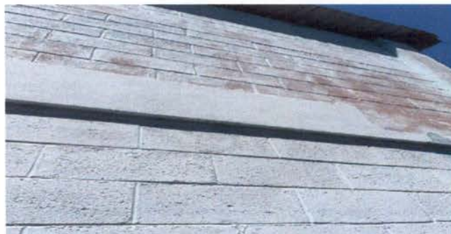
Foto 6: Pintura de paredes exteriores
