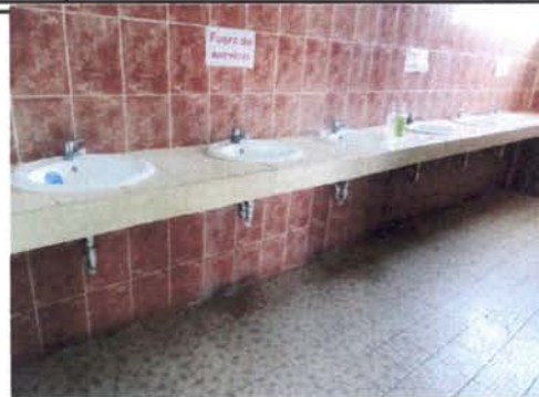
Foto 2: Reparacion de lavamanos
