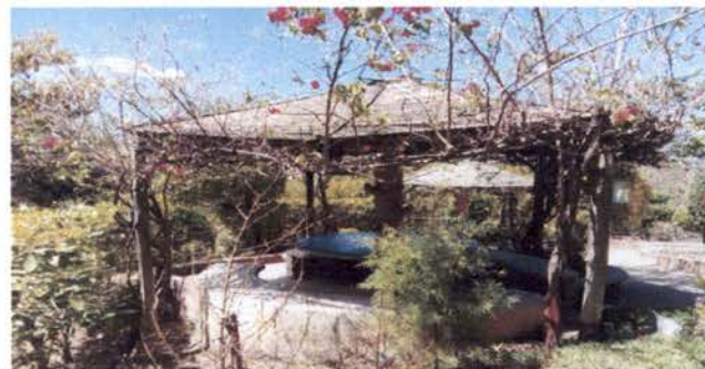
Foto2: Reparación de estructura portante y techo
