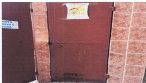
Foto 1: Mantenimiento a puertas de metal de los baños
