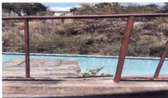
Foto 3: Mantenimiento a barandas de metal
