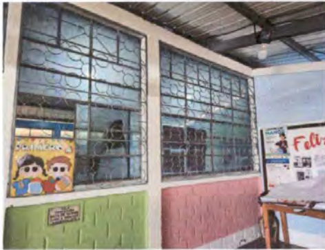
Foto 7: Mantenimiento de balcones de metal, pintura
