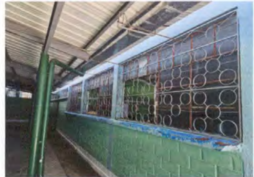
Foto 14: Mantenimiento de balcones de metal, pintura
