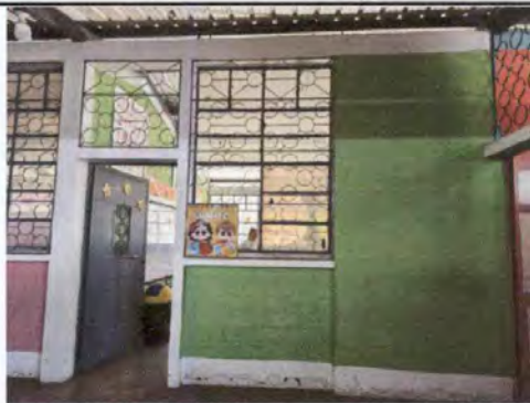
Foto 15: Mantenimiento de balcones de metal, pintura
