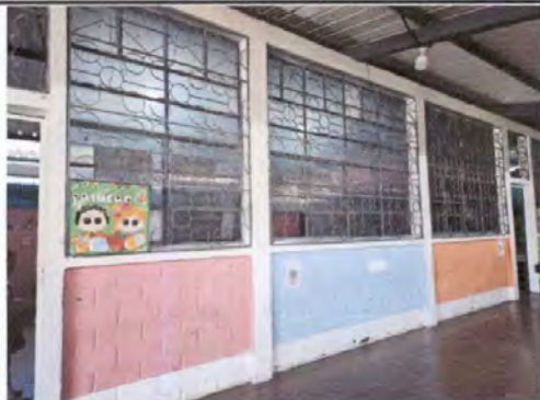
Foto 9: Mantenimiento de balcones de metal, pintura
