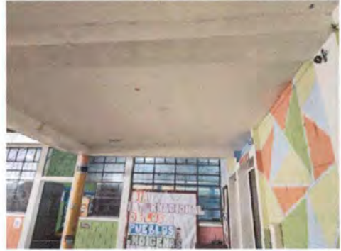
Foto 20: Imprimeabilización en terraza.
