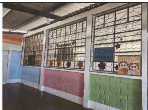
Foto 3: Mantenimiento de bolcones de metal, pintura
