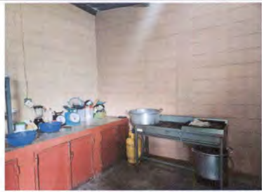
Foto 26: Instalación de azulejo en la cocina
