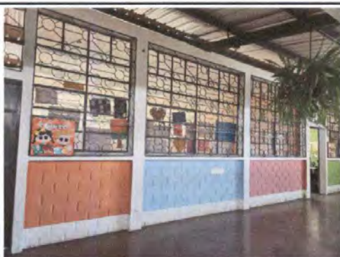
Foto 5: Mantenimiento de bolcones de metal, pintura
