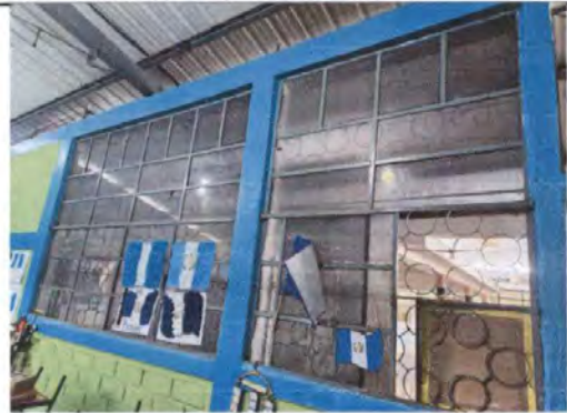
Foto 8: Sustitución de estructura de ventana mas vidrio
