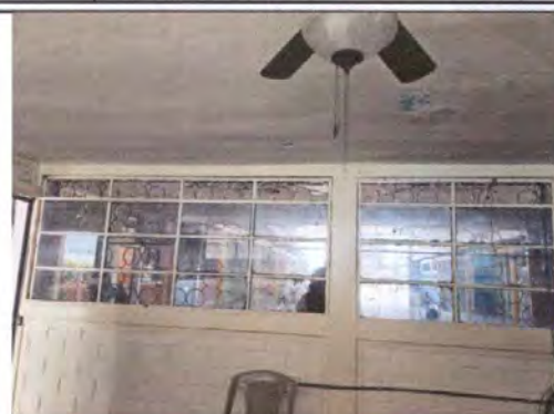
Foto 2: Sustitución de estructura de ventana y vidrio
