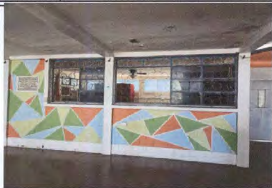
Foto 1: Mantenimiento de bolcones de metal, pintura
