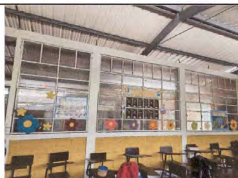
Foto 4: Sustitución de estructura de ventana y vidrio
