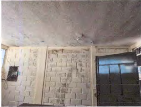
Foto 19: Imprimeabilización en terraza.
