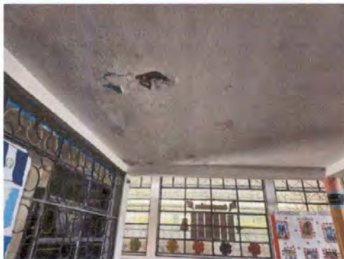
Foto 21: Imprimeabilización en terraza.
