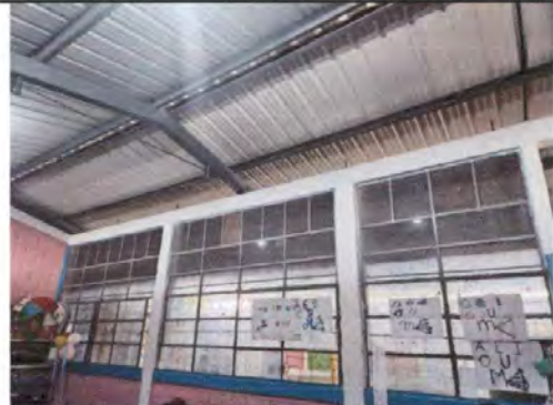
Foto 10: Sustitución de estructura de ventana mas vidrio
