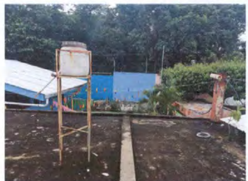
Foto 22: Imprimeabilización en terraza.
