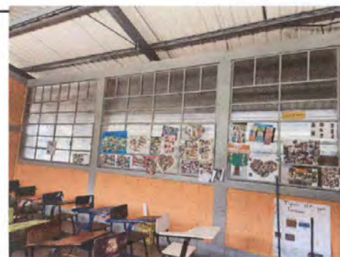
Foto 6: Sustitución de estructura de ventana y vidrio
