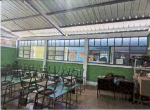
Foto 13: sustitución de vidrio
