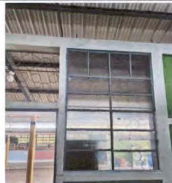
Foto 18: Sustitución de estructura de ventana mas vidrio
