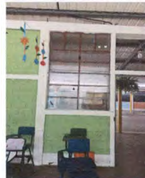
Foto 16: Sustitución de estructura de ventana mas vidrio
