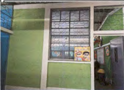
Foto 17: Mantenimiento de balcones de metal, pintura
