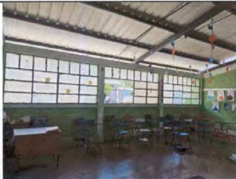
Foto 11: sustitución de vidrio
