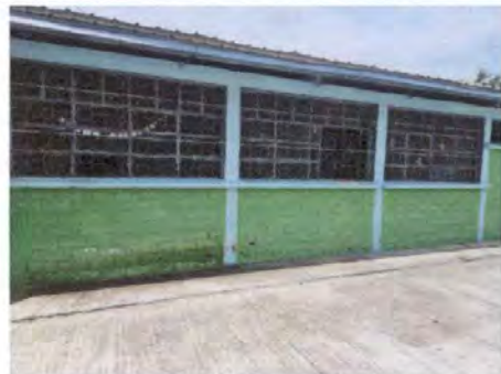
Foto 12: Mantenimiento de balcones de metal, pintura
