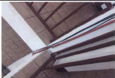
FOTO 5: SUSTITUCIÓN DE DUCTO Y CABLEADO ELÉCTRICO
