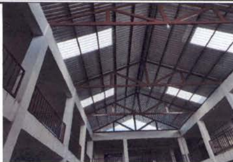
FOTO 2: INSTALACIÓN DE ESTRUCTURA DE SOPORTE DE METAL
