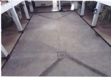
FOTO 6: TRABAJO EXTRA DE MEJORAMIENTO DE DRENAJE DE AGUA PLUVIAL EN PATIO
