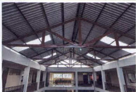
FOTO 1: INSTALACIÓN DE LÁMINA TROQUELADA ALUZINC CALIBRE 26
