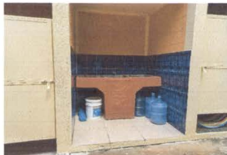
FOTO 8: INSTALACIÓN DE PILAS DE CONCRETO DE DOS LAVADEROS
