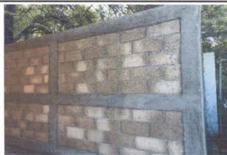
FOTO 6: MEJORAMIENTO DE MURO PERIMETRAL
