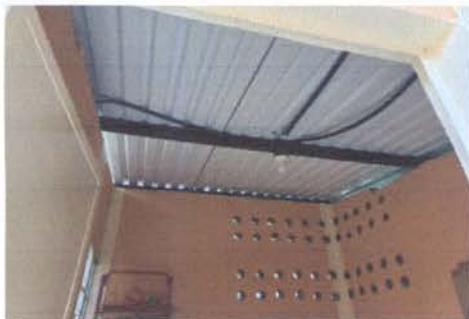
FOTO 1: INSTALACIÓN DE LAMINA TROQUELADA CALIBRE 26
