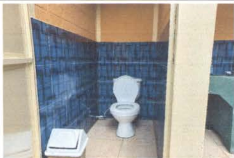
FOTO 3: SUSTITUCIÓN DE INODOROS E INSTALACIÓN DE AZULEJO
