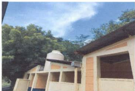
FOTO 7: INSTALACIÓN DE TINACOS
