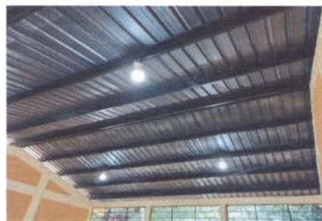
FOTO 4: INSTALACIÓN DE LÁMPARAS LED EN AULAS Y CORREDOR
