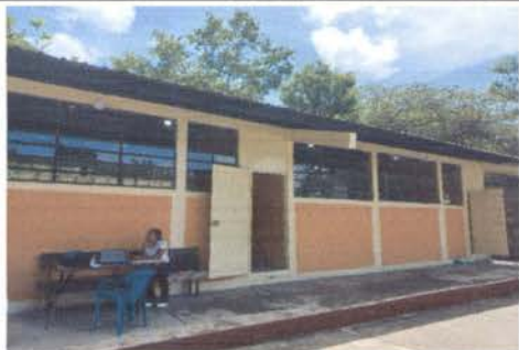
FOTO 9: APLICACIÓN DE PINTURA EN INTERIOR Y EXTERIOR
