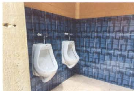
FOTO 2: SUSTITUCIÓN DE MINGITORIOS E INSTALACIÓN DE AZULEJO
