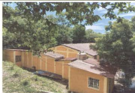
FOTO 10: APLICACIÓN DE PROTECCIÓN ANTICORROSIVA EN TECHOS.
