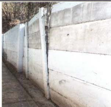
Foto1: Sustrucción de muro perimetral de planchas de concreto por block.
