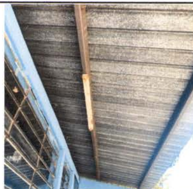
Foto 4: Reparación de lamparas.
