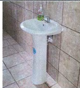
Foto 2: Sustitución de lavamanos servicio sanitario de niñas.
