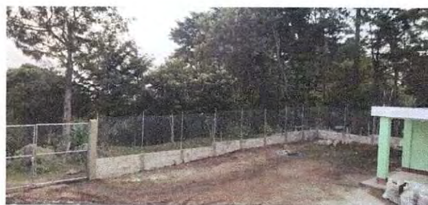
Foto 4: Cerco o muro perimetral.
