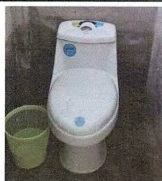
Foto 2: Sustitución de lavamanos servicio sanitario de niñas.
