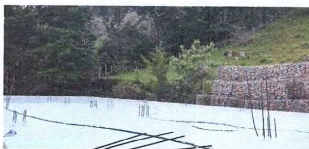
Foto 6: Impermeabilización de losa
