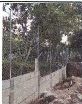
Foto 5: Cerco o muro perimetral.
