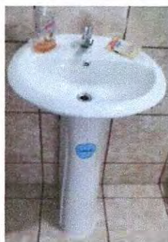
Foto 3: Sustitución de lavamanos servicio sanitario de maestros.
