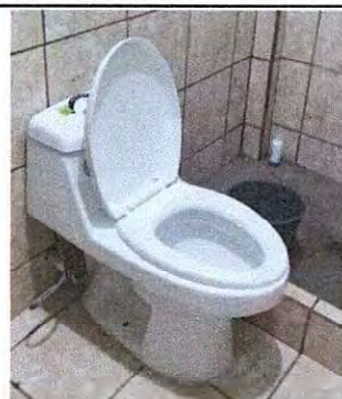
Foto 4: Sustitución de inodoro servicio sanitario de maestros.
