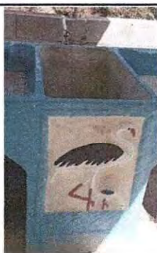
Foto 3: Sustitución de pila de dos lavaderos.
