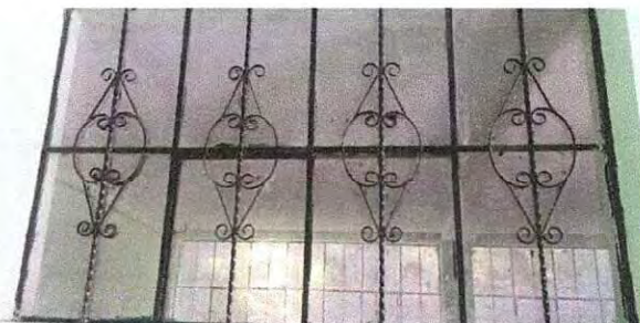
Foto 4: limpieza y aplicación de pintura anticorrosiva.
