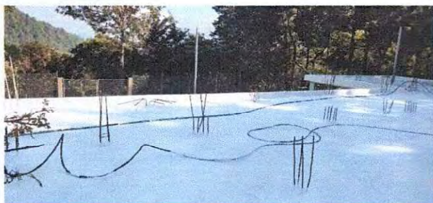
Foto 1: Impermeabilización de losa.
