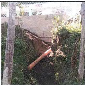
Foto 5: Reparación red de drenaje.
