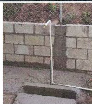
Foto 2: Reparación red de agua potable.
