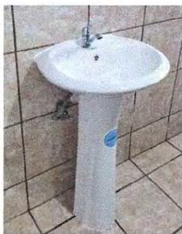
Foto1: Sustitución de lavamanos servicio sanitario de niños.
