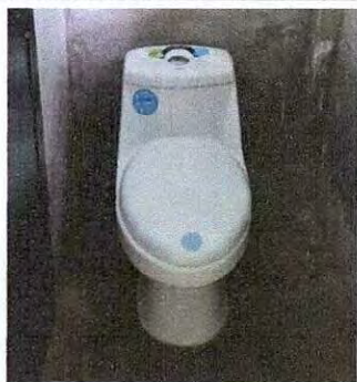
Foto 5: Sustitución de inodoro servicio sanitario de niños.
