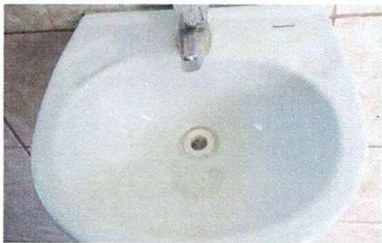
Foto1: Sustrucción de lavamanos servicio sanitario de niños.
