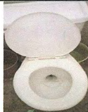
Foto 2: Sustitución de inodoro servicio sanitario de niños.
