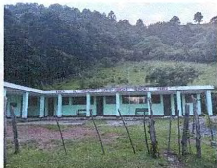
Foto 3: Falta de cerco o muro perimetral
