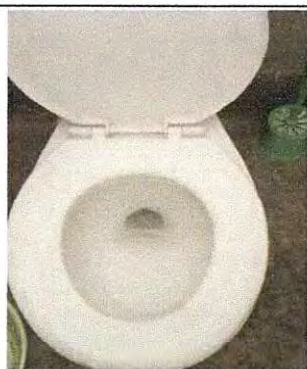
Foto 3: Sustitución de inodoro servicio sanitario de niños.
