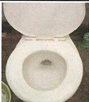
Foto 5: Sustitución de inodoro servicio sanitario de niñas.
