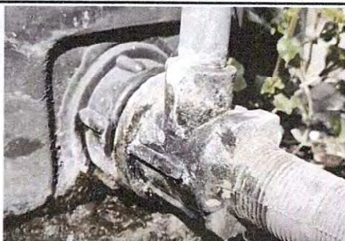
Foto 5: Reparación de cisterna.
