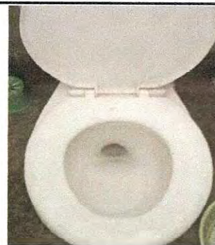
Foto 6: Sustitución de inodoro servicio sanitario de maestros.
