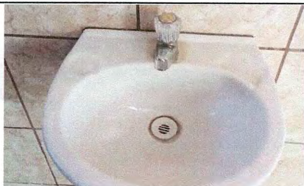
Foto 3: Sustrucción de lavamanos servicio sanitario de maestros.
