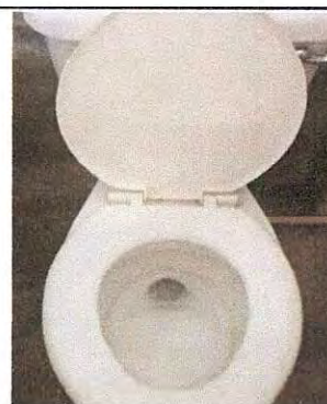
Foto 4: Sustitución de inodoro servicio sanitario de niñas.
