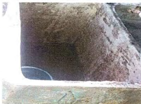
Foto 4: Sustrucción de pila dos lavaderos.
