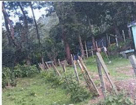
Foto1: Falta de cerco o muro perimetral
