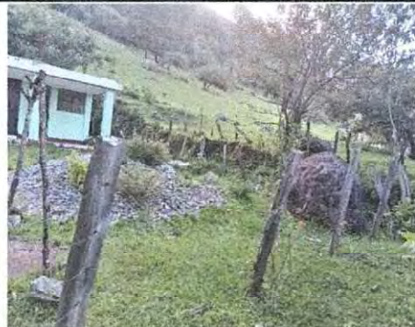
Foto 2: Falta de cerco o muro perimetral
