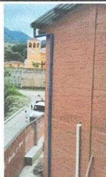
Foto 6: Canal y bajada de agua pluvial
