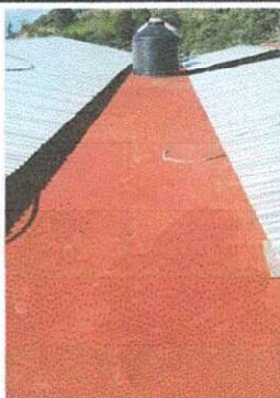
Foto 3: Losa impermeabilizada, la canaleta la cubre a cubierta de la lámina
