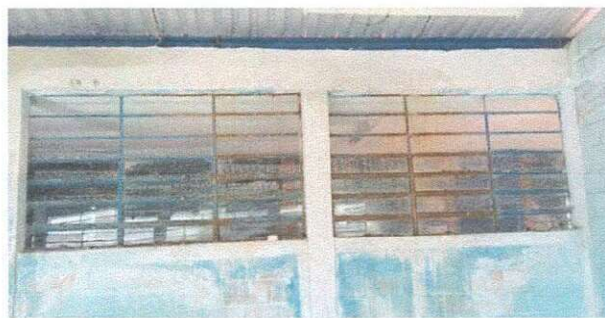
Foto 4: Costanera instalada y pintada
