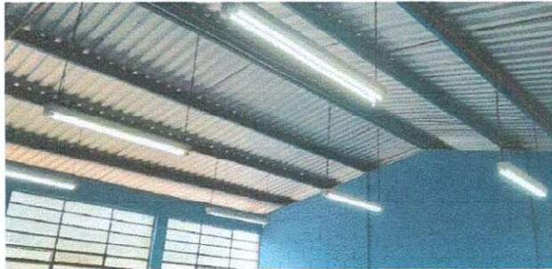
Foto 9: Tubos les instalados
