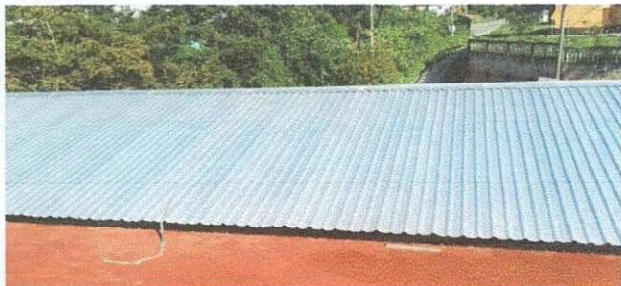
Foto1: Cubierta de lámina instalada
