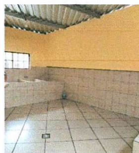
Foto 6: Intalación de azulejo en pila.
