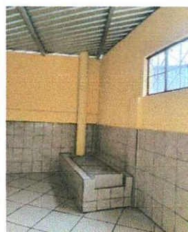
Foto 4: Construcción de estufa rural
