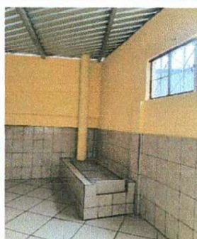
Foto 5: Instalación de techo nuevo
