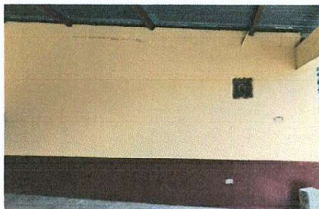
Foto 1: Aplicación de pintura en paredes exteriores
