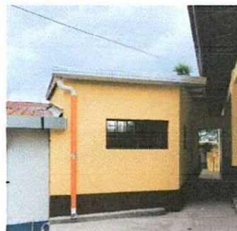
Foto 2: Instalación de canal para aguas pluviales
