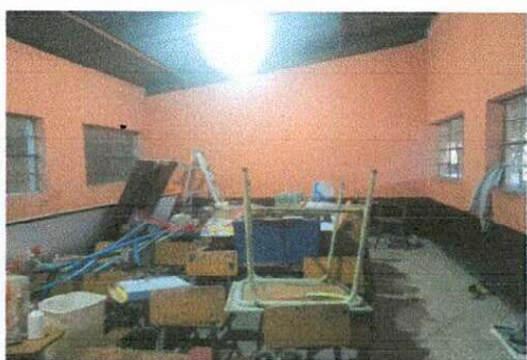
Foto 5: Aplicación de pintura en paredes interiores.
