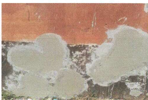
Foto 3: Relleno gujeros en paredes antes de aplicación de pintura
