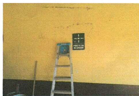
Foto 4: Aplicacion de pintura en paredes exteriores.
