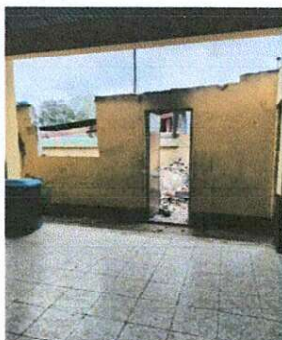
Foto 1: Desmontaje de tech
