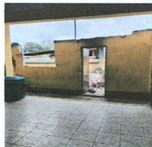
Foto 2: Apertura de ventanas nuevas
