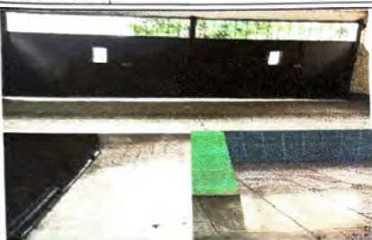
7. Finalización de la sustitución de piso de granito por piso cerámico en cocina. Sustitución de piso de granito por torta de concreto en área de ingreso principal. Nivelación de área de entrada secundaria con mezzón
