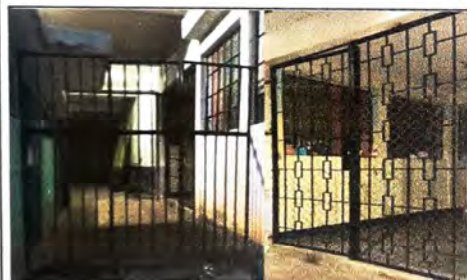
3. Mantenimiento finalizado en rejas de metal en área que da a la cancha polideportiva, ubicadas en el área de Preprimaria
