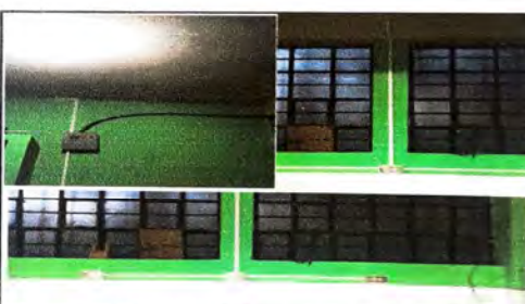
4. Trabajo final de sustitución de focos ahorradores de 30W, sustitución de ducto eléctrico, sustitución de tomacorrientes dobles en cocina
