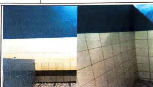
2. Trabajo final de pintura en interior de sanitarios de primer nivel
