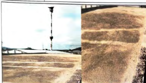
1. Impermeabilización final de losa en área de salón de usos múltiples
