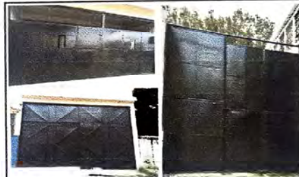
10. Mantenimiento final a portón de entrada principal, mantenimiento a portón del parqueo, mantenimiento y modificación a portón de entrada secundaria an área de Preprimaria
