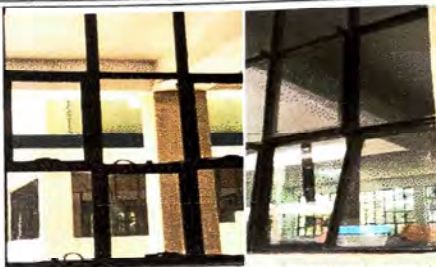
8. Sustitución final de vidrios de diversas medidas en salones de clase
