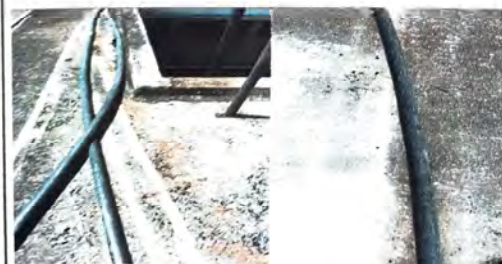
5. Trabajo final en la sustitución de tubería para agua potable que surte los depósitos de la terraza
