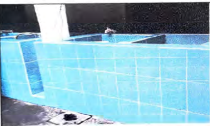
9. Trabajo final de sustitución de azulejo en dos pilas del patio principal
