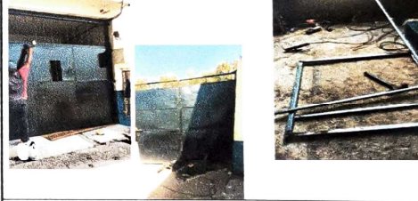
10. Mantenimiento a portón de entrada principal, mantenimiento a portón del parqueo, mantenimiento y modificación a portón de entrada secundaria an área de Preprimaria
