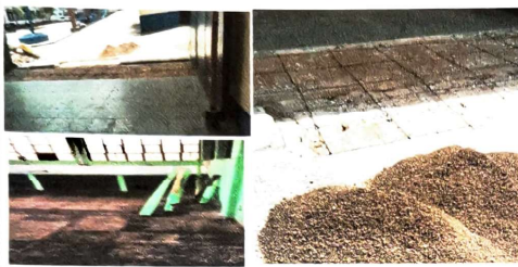
7. Proceso de sustitución de piso de granito por piso cerámico en cocina, Sustitución de piso de granito por torta de concreto en área de ingreso principal. Nivelación de área de entrada secundaria con mezlón
