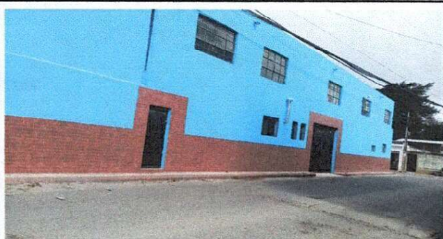
Foto 3: PINTURA GENERAL, podemos notar en la fotografia el deterioro de la pintura del establecimiento, el realizar un pintura genral en todo el establecimiento, dara un mejor aspecto y ayudara a controlar la humedad
