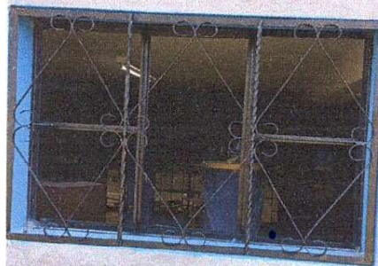
Foto 4: APERTURA DE VENTANAS, permitira la ventilación en las ulas y a controlar la humedad
