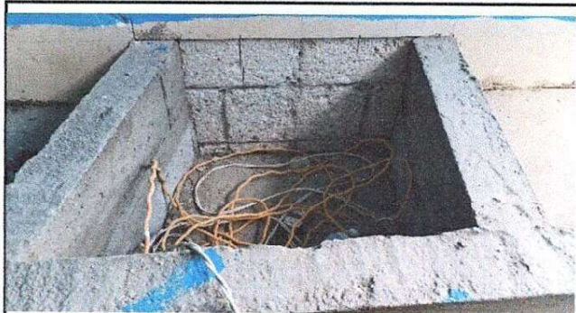
Foto1: CONSTRUCCION DE PILETA, esta pileta quedara mas cerca de nuestra cocina, facilitara el lavar los trastes.
