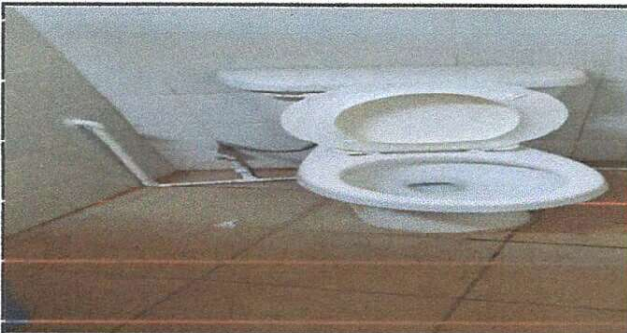
Foto 5: Habilitación de baños de segundo nivel
