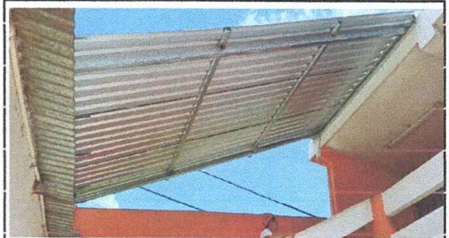
Foto 4: Instalación de techo de gradas, estructura metálica
