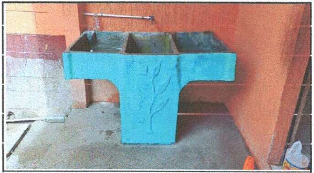
Foto 2: Reparación y traslado de pila, instalación de caja y drenaje
