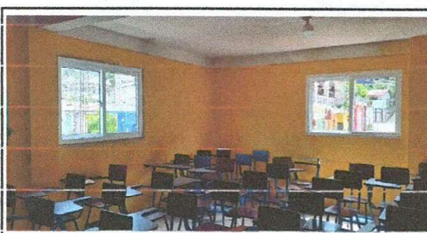
Foto 6: Ventanas de segundo nivel instaladas.
