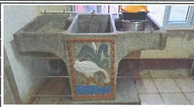
Foto 2: Pila de cocina instalada, caja, drenaje y agua potable
