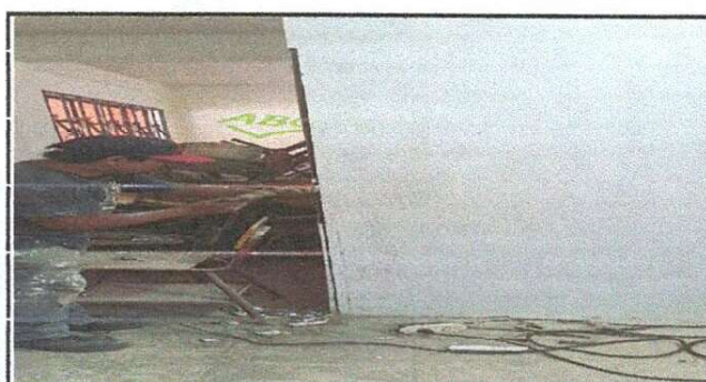
Foto 4: Muro de división en segundo nivel
