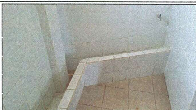
Foto 2: Reparación de sanitarios de segundo nivel
