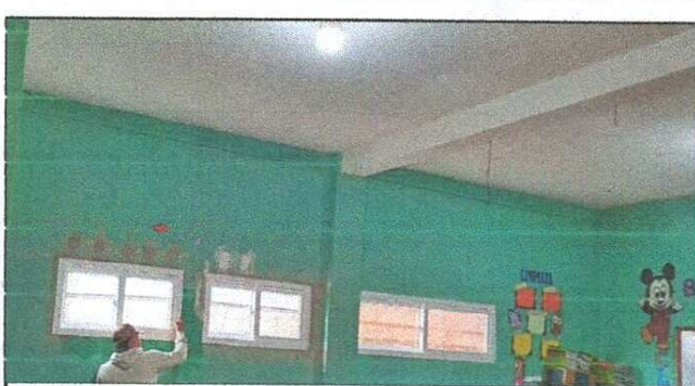
Foto 6: Remodelación de ventanas
