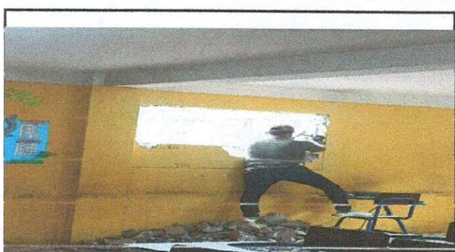
Foto 4: Proceso de remodelación de ventanas
