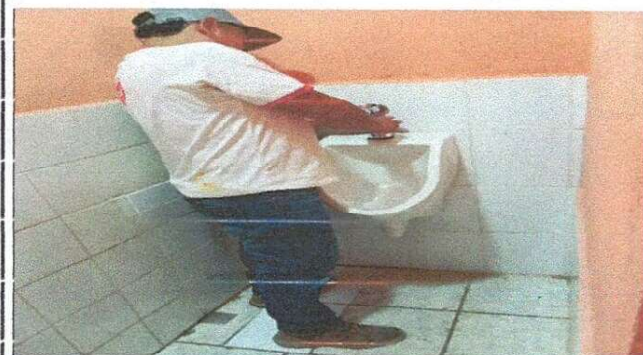
Foto 3: Instalación de migitorios
