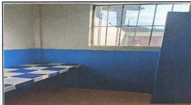
Foto: Ampliación de cocina finalizada
