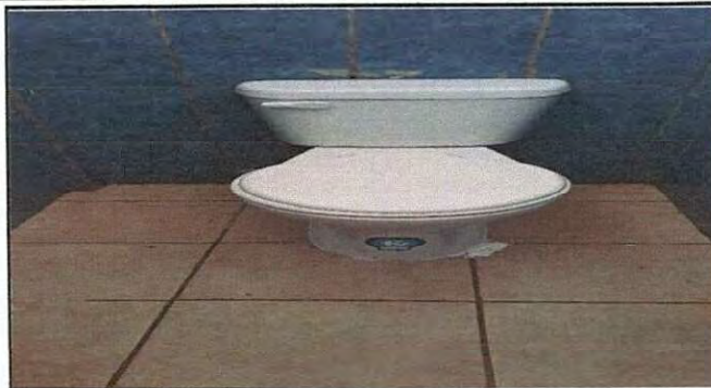
Foto 19: Sanitarios nuevos instalados.
