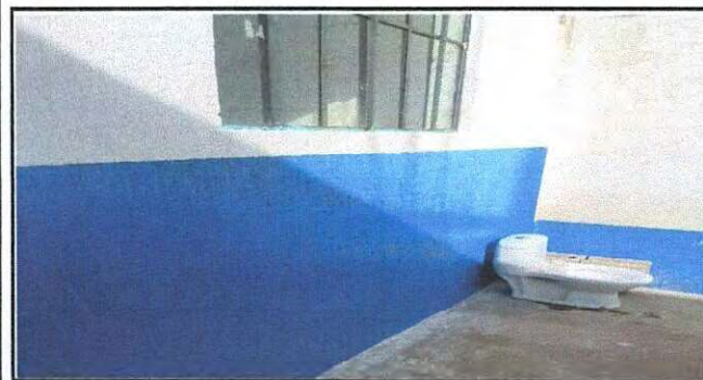
Foto: Muro exterior de cocina finalizado.
