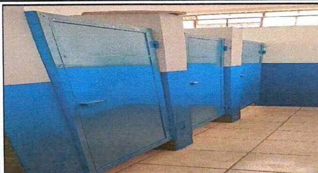
Foto 18: Sanitarios remodelados, puertas restauradas.
