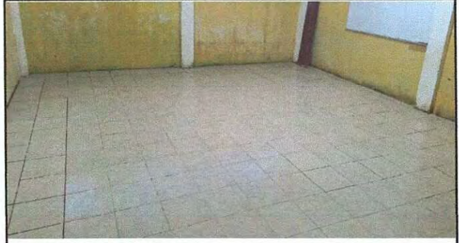
Foto 31: Piso de salón reparado.
