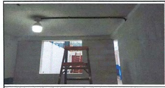
Foto 35: Instalación eléctrica en ampliación de cocina concluida.
