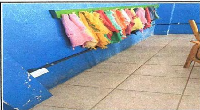
Foto 24: Instalación eléctrica reparada.
