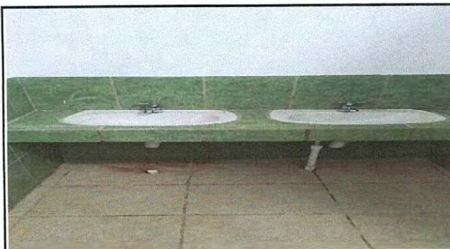
Foto 20: Lavamanos reparados y funcionando.
