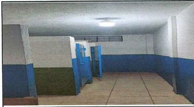
Foto 21: Módulo de baños restaurado.
