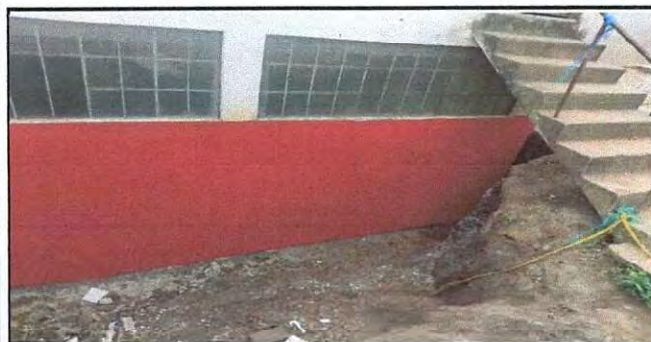
Foto 28: Muro exterior de salones, reparado.
