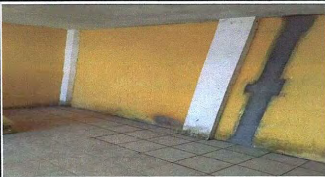
Foto 30: Bajadas de agua reparadas. Caja interior cegada.
