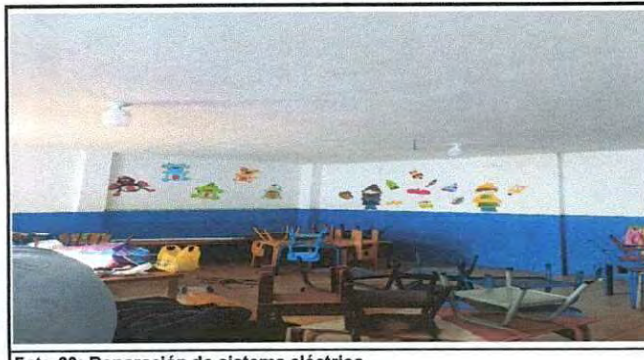
Foto 23: Reparación de sistema eléctrico.
