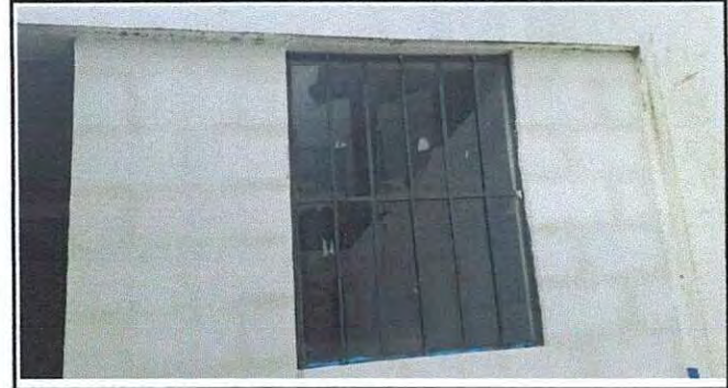
Foto 33: Ampliación de cocina realizada.
