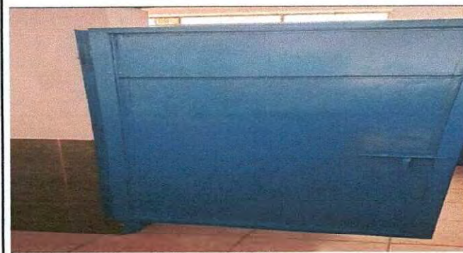
Foto 5: Puertas de sanitarios en reparación
