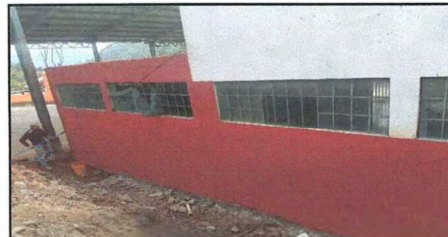
Foto 12: Impermeabilización de mur exterior de salones.
