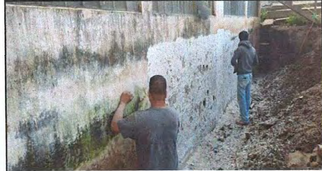
Foto : Reparación de la pared exterior de los salones.
