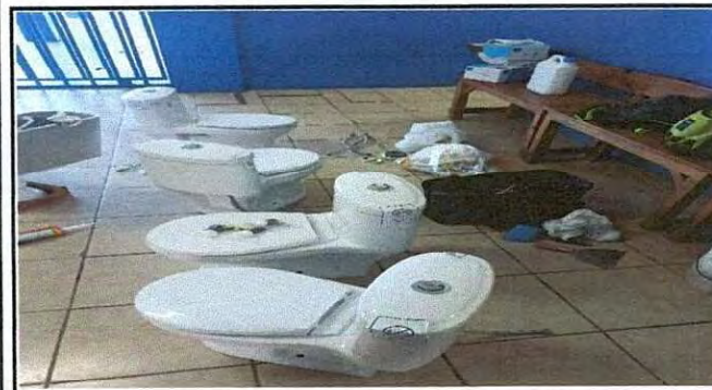
Foto 3: Sustitución de sanitarios grandes y baby
