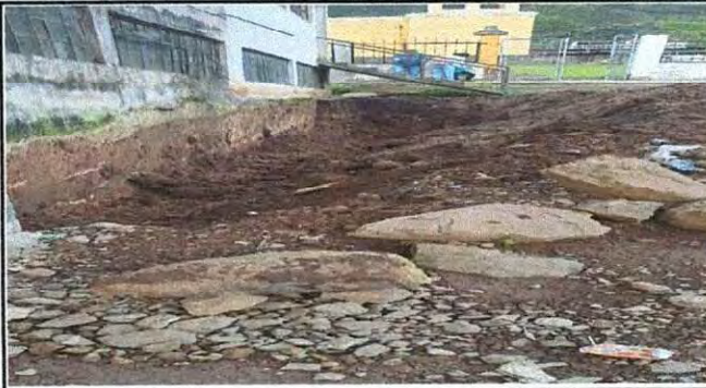
Foto: Zanjeo en la parte exterior de salones para trabajar reparación de muro
