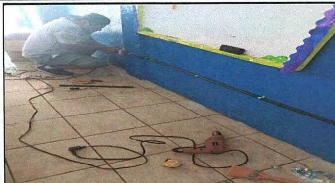
Foto1: Reparación de tendido eléctrico en salones, instalación de apagadores y tomacorrientes.
