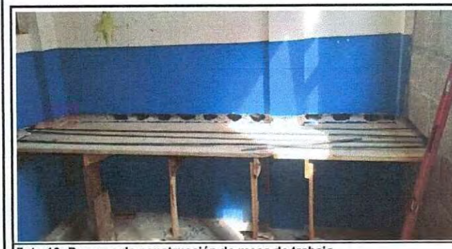
Foto 16: Proceso de construcción de mesa de trabajo.
