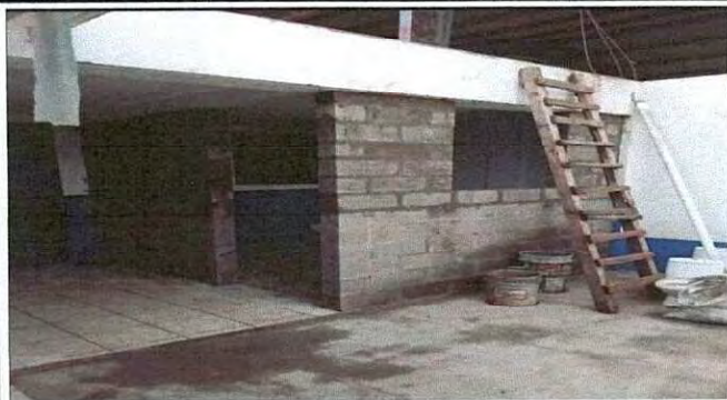
Foto13: Proceso de ampliación de cocina.
