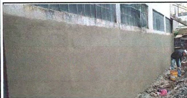
Foto 11: Reparación de muro exterior de salones.
