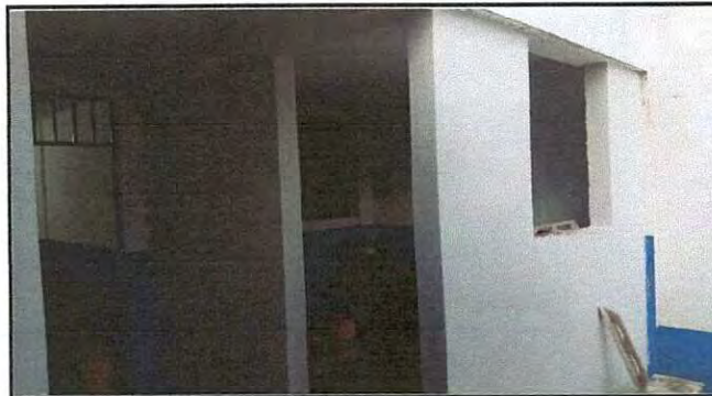
Foto 16: Proceso de ampliación de cocina
