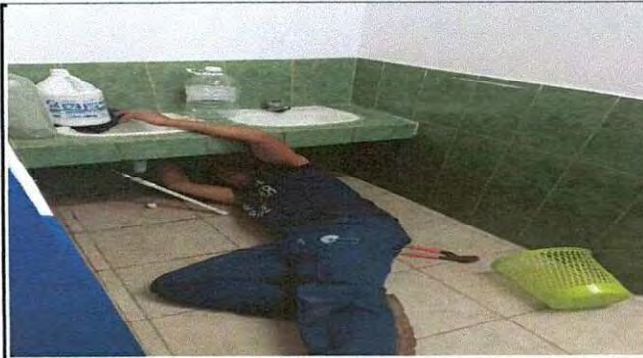
Foto 2: Proceso de reparación de lavamanos y sanitarios
