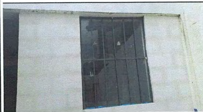
Foto 15: Proceso de ampliación de cocina
