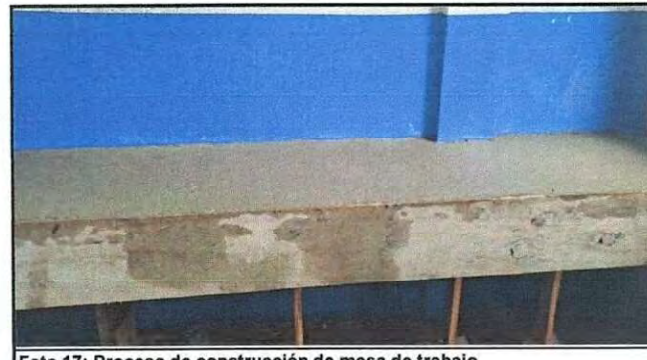
Foto 17: Proceso de construcción de mesa de trabajo.
