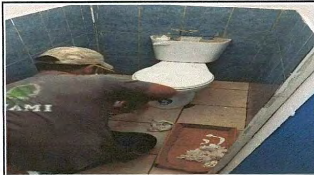
Foto 4: Instalación de sanitarios.
