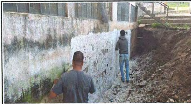
Foto : Reparación de la pared exterior de los salones.
