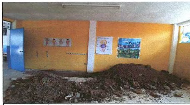
Foto 6: Reparación de salón.
