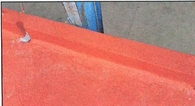
FOTO 8 Fundición de remates de terraza
