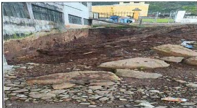
FOTO 9 Zanjeo en muro exterior de salones
