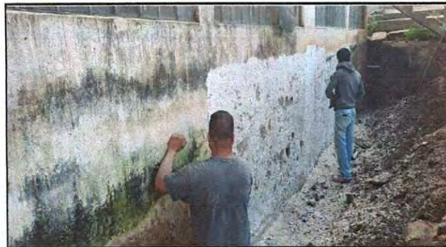
Foto 10; Trabajos de reparación de muro exterior de salones
