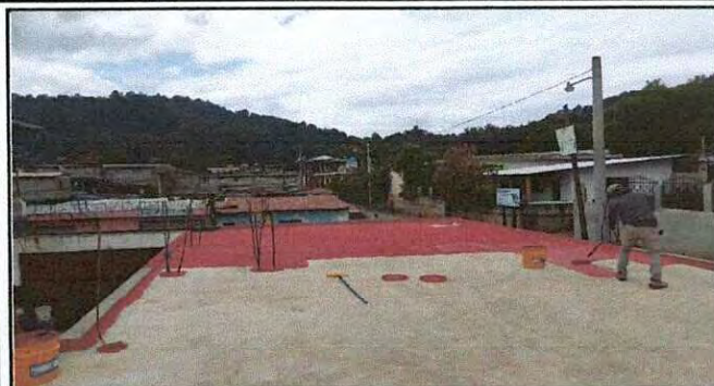
FOTO 7 Proceso de reparación de terraza
