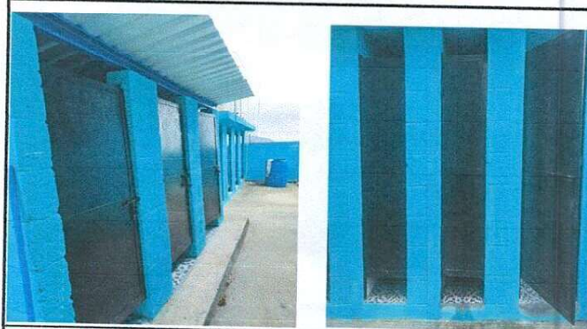
Foto 3-1,3-2,3-3: INSTALACION DE SANITARIOS BLANCOS,INSTALACION DE AGUA Y DRENAJES,REPARACION DE TECHO DE LAMINA DE SANITARIO,INCLUYECAMBIO DE LAMINATROQUELADACALIBRE 26,REFORZAMIENTODE BASE METALICAJUO Y PINTURA, MANTENIMIENTO DE PUERTAS CAMBIO DE LIENZO A 3 DE LAS 7 PUERTAS.
