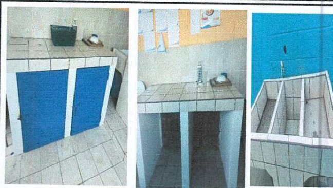
Foto 2: REPARACION O SUSTITUCION DE AREA DE COCINA (SUMINISTRO DE 3 MESAS DE CONCRETO DE (0.70X2.00X.80)(0.70X2.90X.80, INCLUYE 4 PUERTAS DE METAL DE 0.50X0.70 CADA UNA)(0.70X1.20X0.80) FORRADO CON AZULEJO.
