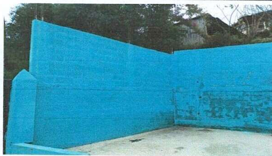
Foto 9: CERCO O MURO PERIMETRAL (SUMINISTRO DE MURO PERIMETRAL DE 1.80X4.30 METROS PARA COMPLETAR MURO YA EXISTENTE)
