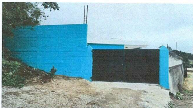
Foto 6: MANTENIMIENTO A PORTONES (MANTENIMIENTO DE PORTON PRINCIPAL DE 6 M2 CON REPARACIÓN DE LIENZO DE LIENZO DE 0.30 METROS, LIMPIEZA, LUJADO Y PINTURA)
