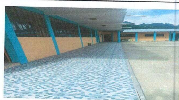
Foto5: piso(suministro e instalacion de 65 metros cuadrados de piso antideslizante en area de corredor principal y servicios sanitarios y colocacion de azulejo area de sanitarios
