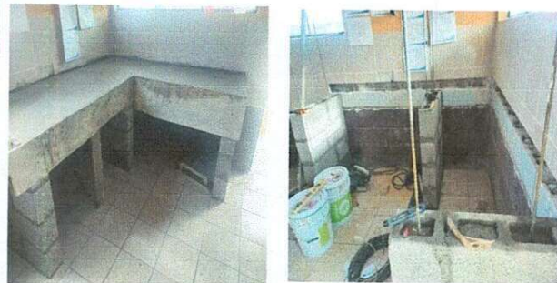
Foto 2: REPARACION O SUSTITUCION DE AREA DE COCINA (SUMINISTRO DE 3 MESAS DE CONCRETO DE(0.70X2.00X.80)(0.70X2.90X.80,INCLUYE 4 PUERTAS DE METAL DE0.50X0.70 CADA UNA)(0.70X1.20X0.80) FORRADO CON AZULEJO.
