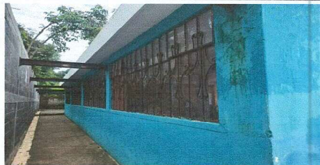
Foto 7: VENTANAS: MANTENIMIENTO A 52 A 52 MT2 DE BALCONES (Limpieza, lijado y pintura)
