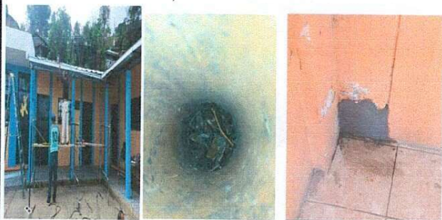
Foto1: CANALES Y BAJADAS DE AGUA PLUVIAL (SUSTITUCION DE CANAL METALICO DE 44.00 MTS. CON 2Sujetadores METALICOS EN AREA DE BODEGA DE ALIMENTOS. SUMINISTRO E INSTALACION DE BAJADAS PLUVIALES 12.00 UNIDADES, Y REPARACION DE BAJADA PLUVIAL DE PARED.
