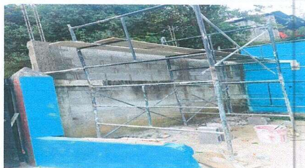
Foto 9: CERCO O MURO PERIMETRAL (SUMINISTRO DE MURO PERIMETRAL DE 1.80X4.30 METROS PARA COMPLETAR MURO YA EXISTENTE)
