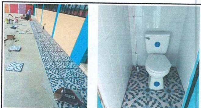
Foto5: piso(suministro e instalacion de 65 metros cuadrados de piso antidecizante en area de corredor principal y servicios sanitarios y colocacion de azulejo area de sanitarios
