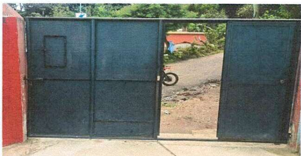
Foto 6: MANTENIMIENTO A PORTONES (MANTENIMIENTO DE PORTON PRINCIPAL DE 6 M2 CON REPARACION DE LIENZO DE LIENZO DE 0.30 METROS, LIMPIEZA, LIJADO Y PINTURA)
