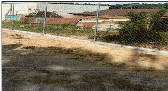
Foto 1: Reparación de muro perimetral
