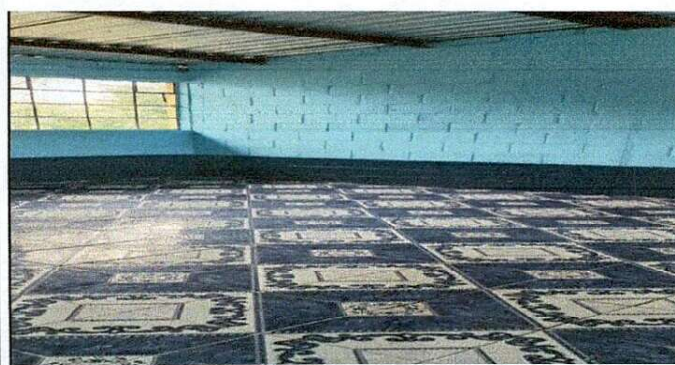
Foto 5: Cambio de pintura
