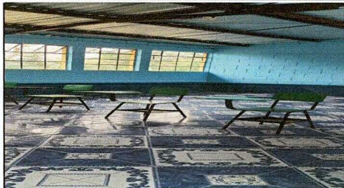
Foto 2: Sustitución de piso
