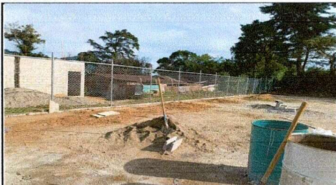
Foto 1: Reparación de muro perimetral
