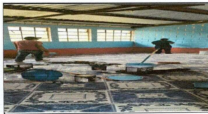
Foto 6: Cambio de pintura
