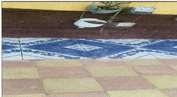
Foto 2: Sustitución de piso
