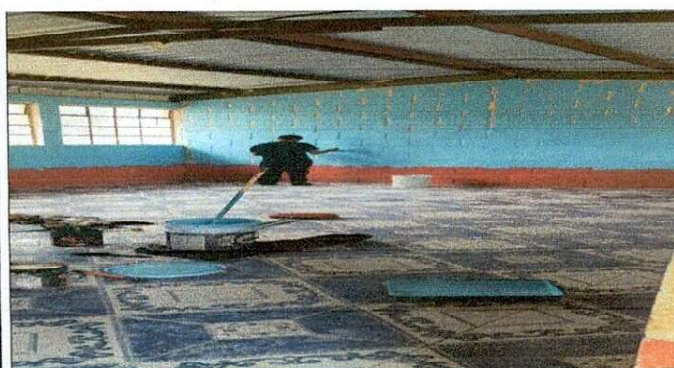
Foto 5: Cambio de pintura
