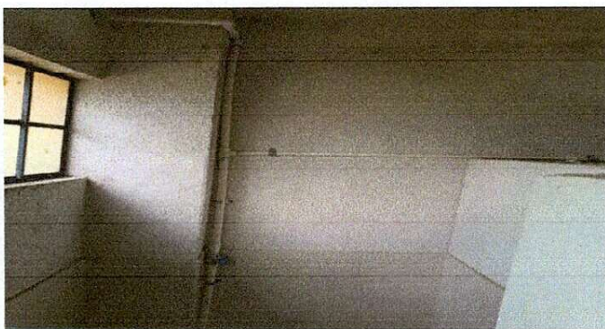
Foto 3: Instalación de tinaco y reparación de tuberías
