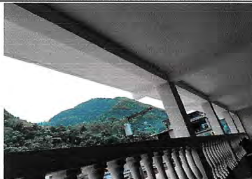
Foto 2: PINTURA DE MUROS EXTERIORES E INTERIORES
