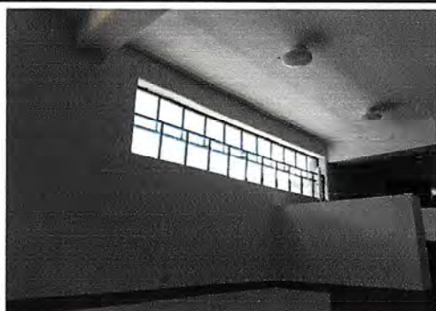
Foto 3: MANENIMIENTO DE VENTANAS DE METAL Y CAMBIO DE VIDRIOS
