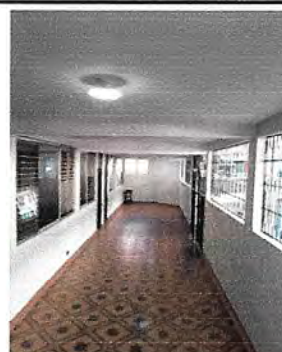
Foto 4: PINTURA DE MUROS INTERIORES Y COLOCACIÓN DE LÁMPARAS PRIMER NIVEL Y MANENIMIENTO DE BALCONES
