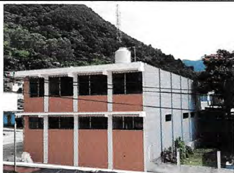
Foto1: PINTURA DE MUROS EXTERIORES
