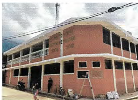
Foto 4: PINTURA DE MUROS EXTERIORES
