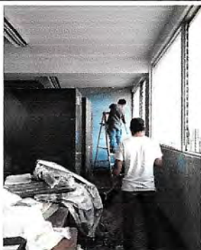
Foto1: PINTURA DE MUROS INTERIORES
