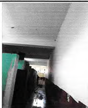
Foto 3: PINTURA DE MUROS INTERIORES (SANITARIOS)
