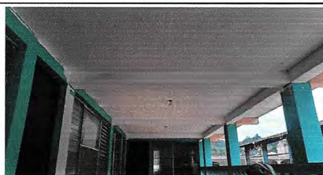
Foto 6: PINTURA DE MUROS INTERIORES
