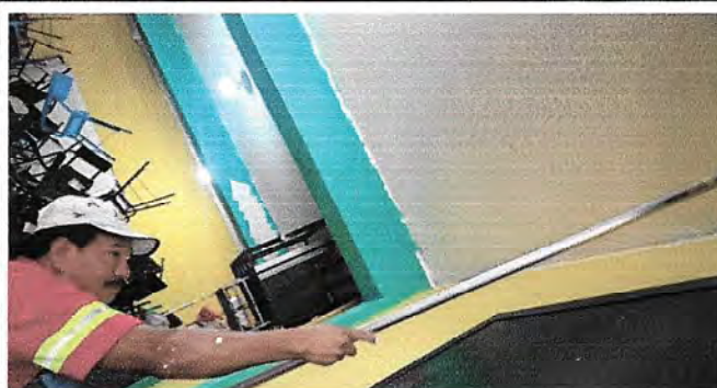
Foto 2: PINTURA DE MUROS INTERIORES
