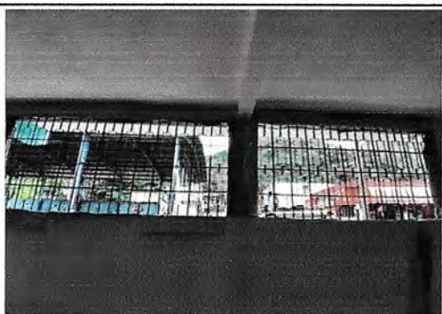
Foto 5: MANTENIMIENTO A BALCONES DE METAL
