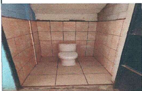
Sanitario preprimaria: colocación de sanitario beby, azulejo y piso cerámico
