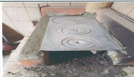
cocina: colocación de estufas rurales.
