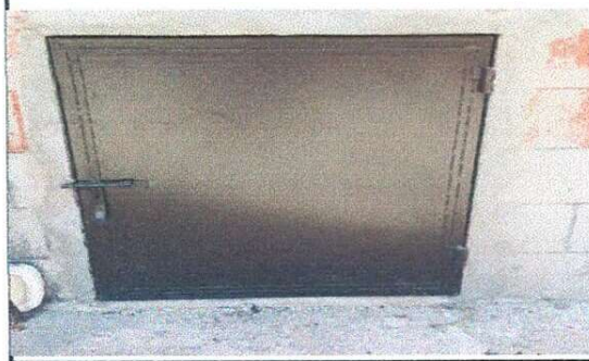
Basurero ; colocación de puerta
