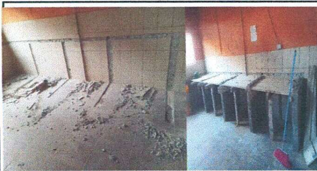
Cocina: construccion de muebles
