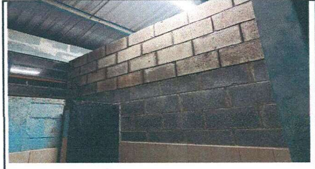
Pared: Reconstrucción de Pared en baños
