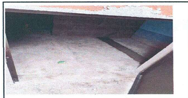
Basurero: Reparacion de grietas
