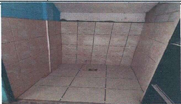
Sanitario preprimaria: colocación de azulejo y piso cerámico
