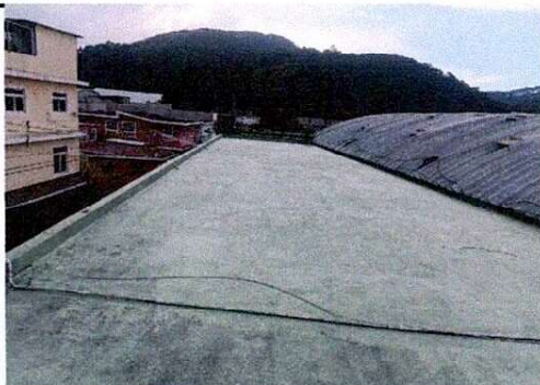
Foto 5: Impermeabilización de losa, se necesita terminar de impermeabilizar la losa y de esta forma evitar filtraciones de agua.
