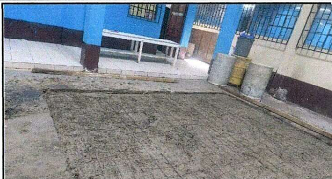
Foto 1: Hundimiento por deterioro de losa, se puede notar un notable hundimiento y al momento de pisar esa area se puede sentir un pequeño movimiento.
