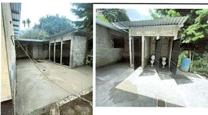
FOTO: 10 Y 11: SERVICIOS SANITARIOS DE LETRINAS SUSTITUIDOS POR INODOROS LAVABLES, Y CAMBIO DE CUBIERTA DE TECHO Y PAREDES.
