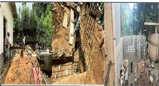
FOTO: 12, 13 Y 14: AREA DE COCINA, PAREDES DE MADERA EN MAL ESTADO Y TECHO, SUSTITUYENDOSE POR PAREDES DE BLOCK Y CUBIERTA DE LAMINA Y ESTRUCTURA DE METAL.
