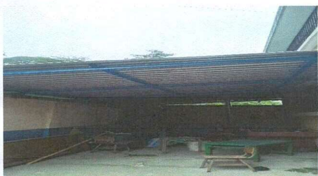
Foto 3: Exterior área de cocina, sustitución de techo de lámina de 12.20 metros cuadrados
