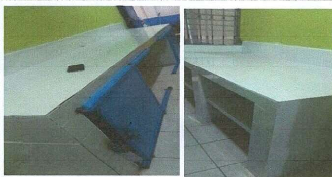
Foto 5: Interior área de cocina, instalación de top planchas de concreto y azulejo
