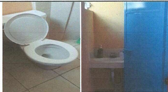
Foto 2: Área de servicio sanitario en mal estado, tapa rota y fuga de agua por estar quebrado, y puerta quebrada
