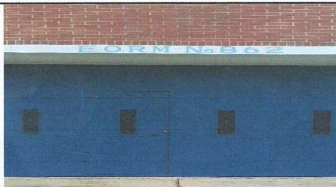
Foto1: Área: Portón principal, limpieza, lijado y pintura
