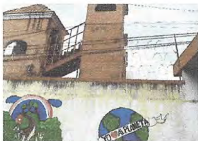
Foto 9: Cerco y muro perimetral
