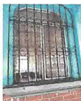
Foto 3: Sustitución, suministro e instalación de vidrios
