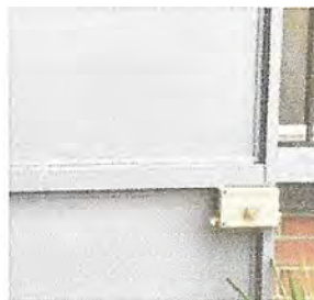
Foto 2: Sustitución, suministro e instalación de chapa yale 60 mm
