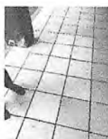
Foto 4: Sustitución de piso en mal estado
