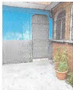
Foto 1: Suministro e instalación de puerta de metal con chapa yale 60 mm
