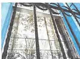
Foto 3: Sustitución, suministro e instalación de vidrios
