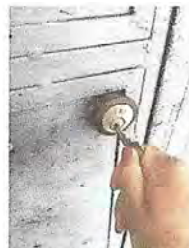
Foto 2: Sustitución de chapas Yale de 60 mm
