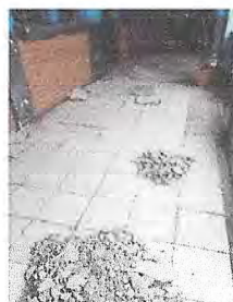
Foto 4: Sustitución de piso en mal estado
