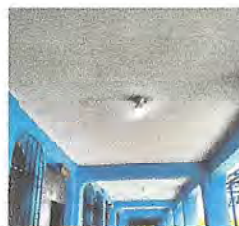
Foto 8: Reparación red eléctrica
