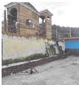
Foto 9: Cerco muro perimetral
