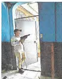
Foto1: Suministro e instalación de puerta de metal con chapa Yale 60 mm
