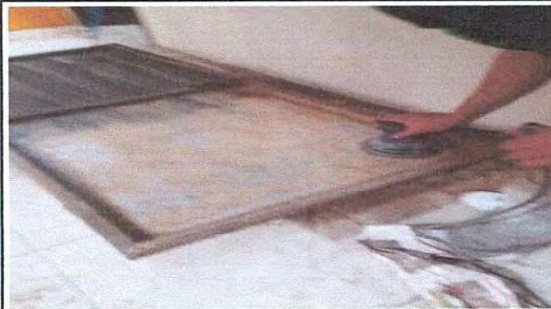
Foto 2: Lijado y aplicación de pintura anticorrosiva
