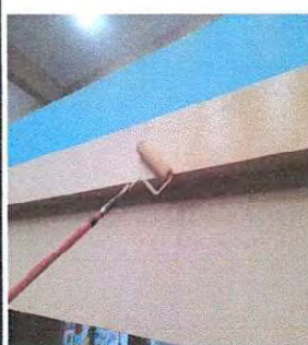
Foto 2: Aplicación de pintura
