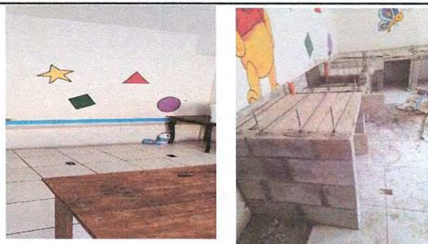
Foto1: Cocina utilizando mesa de madera, solo existia 1 pila para uso general.
