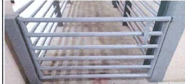
Foto 6: Baranda Lijada y pintada, pintura anticorrosiva.
