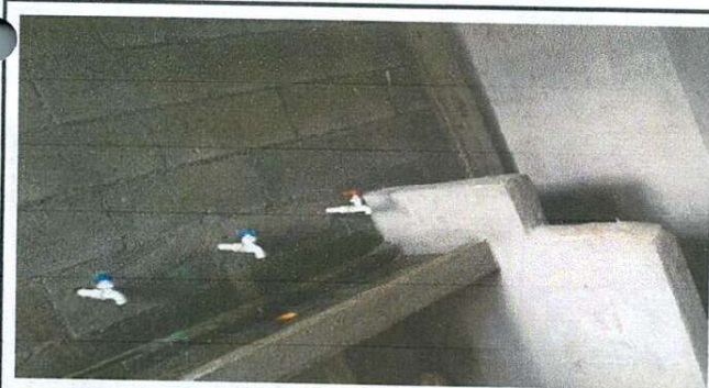
Instalación de un mingitorio de concreto In situ
