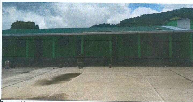
Reparación de planchas de concreto(patio)
