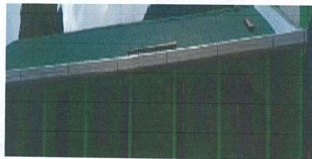
Instalación de canales de pvc
