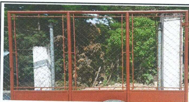
mantenimiento a portones de metal
