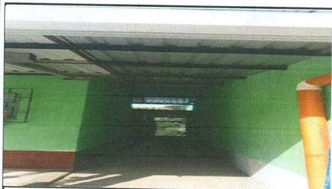
Sustitución de lámina troquelada aluzinc calibre 26
