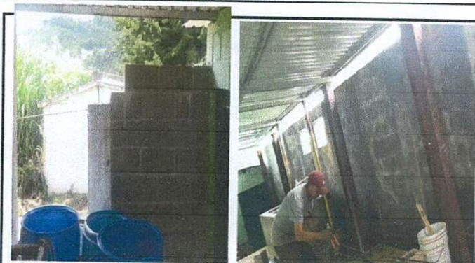
REPARACIÓN DE MURO PERIMETRAL
