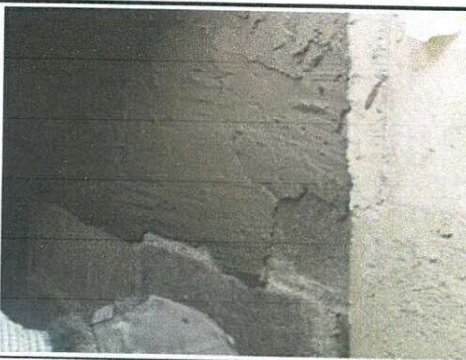
Instalación de un mingitorio de concreto in situ
