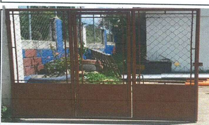
mantenimiento a portones de metal
