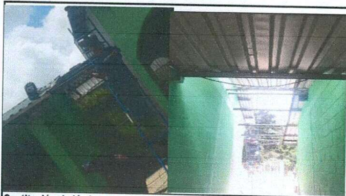
Sustitución de lámina troquelada aluzinc calibre 26
