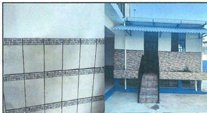
Sustitución de Azulejo y fachaleta en el área de cocina.
