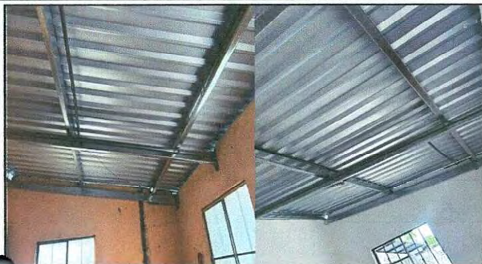
Sustitución de cubierta de lámina por lamina nueva troquelada calibre 26 en area de cocina.
