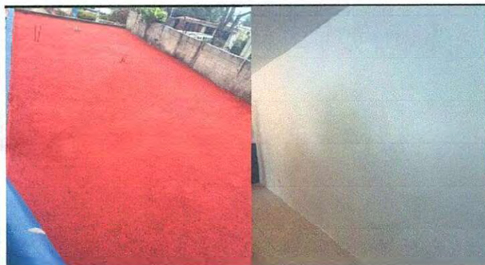
Impermeabilización de loza.
