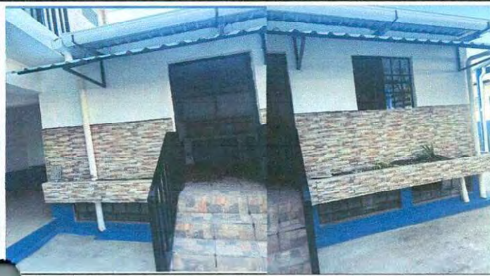
Sustitución de canal de PVC, sustitución de bajada de agua pluvial por tubo PVC y sustitución de soporte de metal para canal.
