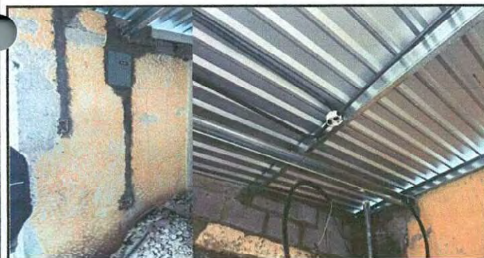
Reparación de sistema eléctrico, sustitución de focos ahorradores, sustitución de interruptores dobles, sustitución de cableado eléctrico, sustitución de duaeléctrico con accesorios.
