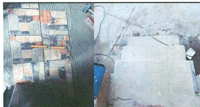
Susutitución de piso cerámico antideslizante en cocina y gradas.
