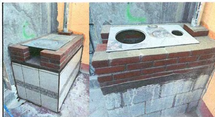
Elaboración de una coina de leña con plancha, incluida la chimenea.
