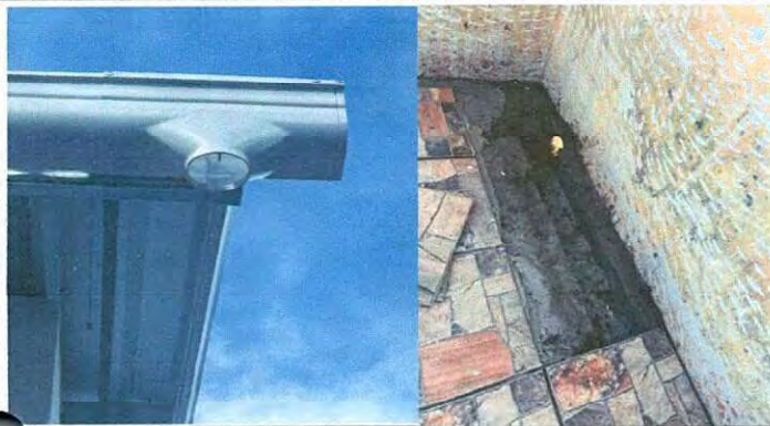
Sustitución de canal de PVC , sustitución de bajada de agua pluvial por tubo PVC y sustitución de soporte de metal para canal.
