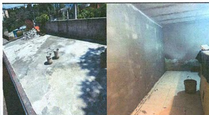
Impermeabilización de loza.
