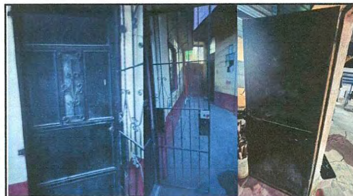
Mantenimiento de estructura, lijado y aplicación de pintura a puerta y reja, sustitución de puerta metálica.
