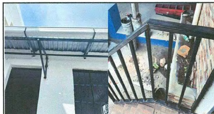
Trabajos adicionales: Colocación de pestaña y pasamanos en la entrada de la cocina.
