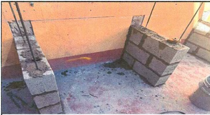
Elaboración de una estufa de leña con plancha, incluida chimenea.
