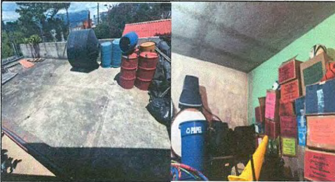
Impermeabilización de loza.
