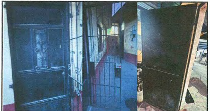
Mantenimiento de estructura, lijado y aplicación de pintura a puerta y reja, sustitución de puerta metálica.
