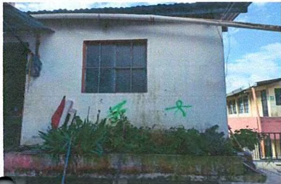
Sustitución de canal de PVC , sustitución de bajada de agua pluvial por tubo PVC y sustitución de soporte de metal para canal.
