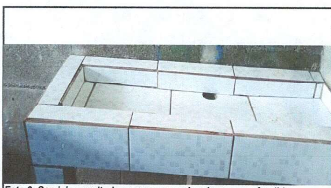
Foto 6: Servicios sanitarios y sus accesorios: lavamanos fundido
