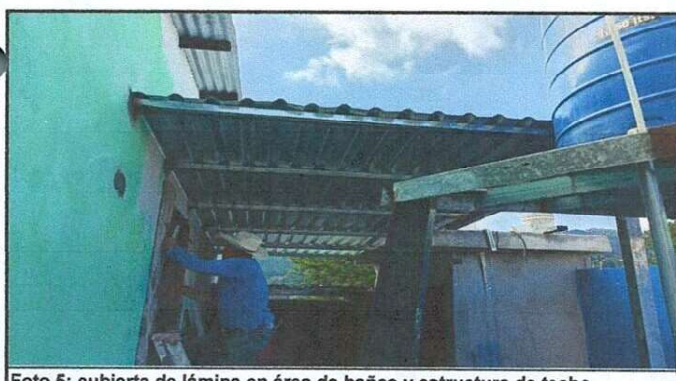
Foto 5: cubierta de lámina en área de baños y estructura de techo
