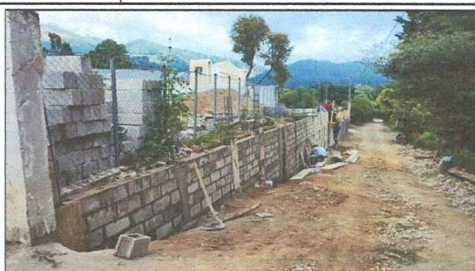
Foto 2: construcción de muro perimetral
