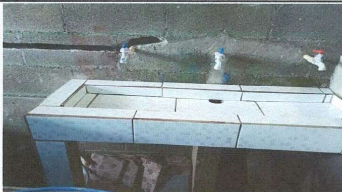
Foto 1: instalación de azulejo
