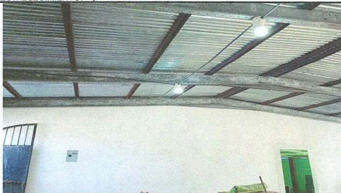
Foto1: Reparación del sistema eléctrico
