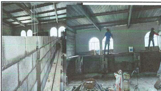
Foto 3: Reparación de repello y cernido de paredes y división de módulo en salón de clases.
