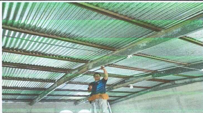
Foto1: Reparación del sistema eléctrico
