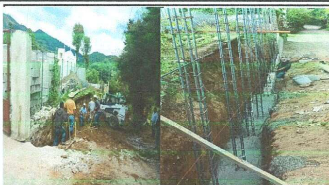
Foto 2: construcción de muro perimetral
