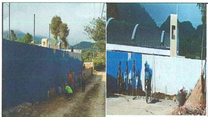
Foto 4: Pintura en muros interiores y exteriores
